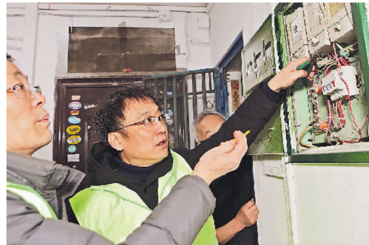
张小蔚(右)在社区独居老人检查电路、更换电线。
