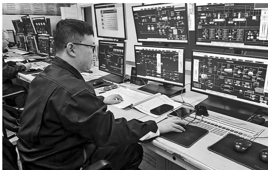
陈愉聪正在热电厂汽机中控室内控制各项参数。本报记者 张婧 摄
