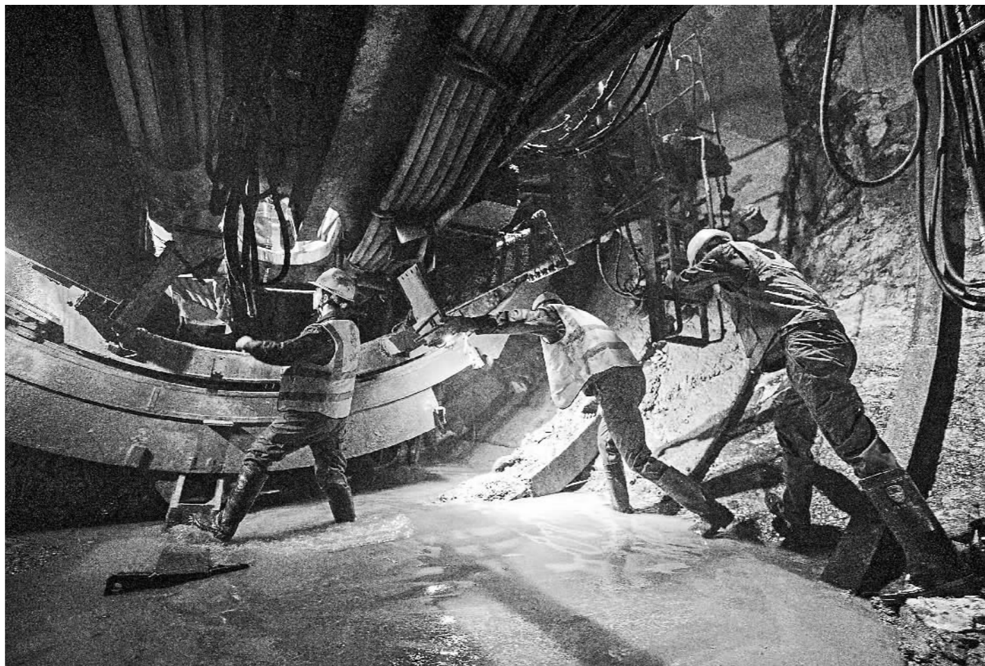
8月25日,位于新疆维吾尔自治区巴音郭楞蒙古自治州的天山胜利隧道施工现场,中国交建新疆乌尉公路项目部工人正蹬水进入隧道,对掘进机进行检修。天山胜利隧道穿越天山山脉,全长22.13公里,建设工期6年,施工难度大,建成后将成为世界上最长的高速公路隧道。 本报记者 王伟伟 摄
