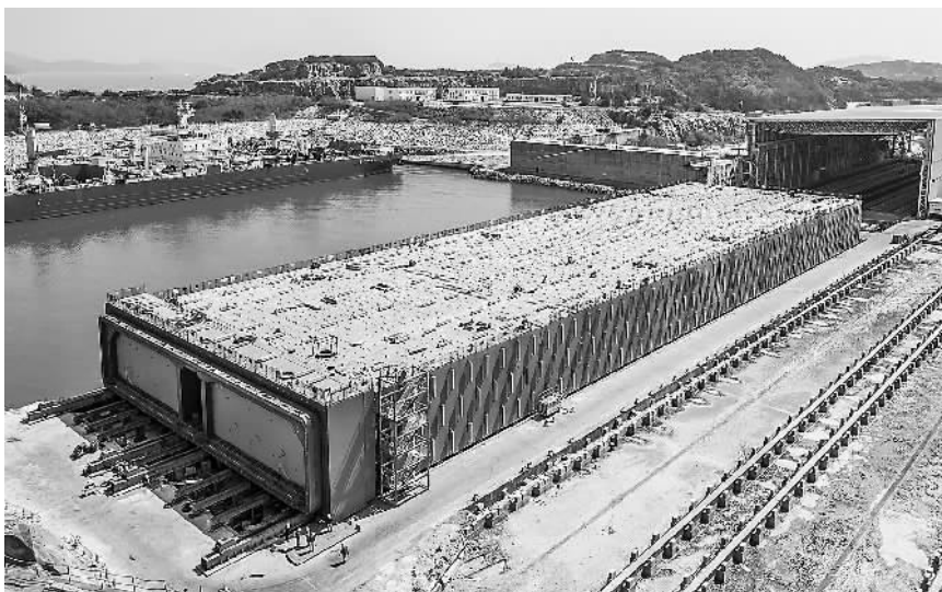
E23管节及最终接头完成预制,即将下水。
